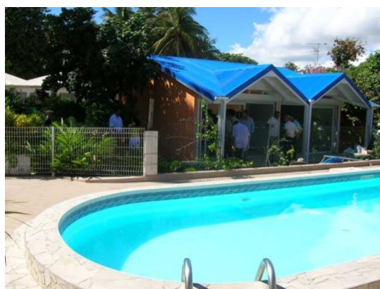
Après les travaux
